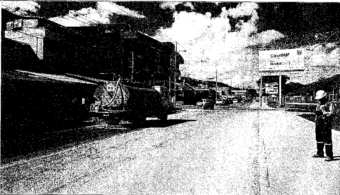
Fotografía 4. Hidratación de vías de acceso a frentes de obra para mitigar la producción de material particulado
