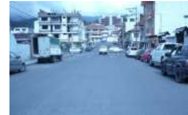
FOTO: Calle Cética desde la calle 18 de Noviembre.
