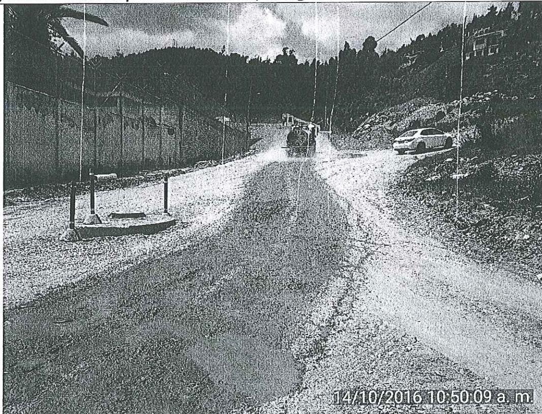
Fotografía 8. Control de polvo constante vía, de ingreso al área de la Criba.
