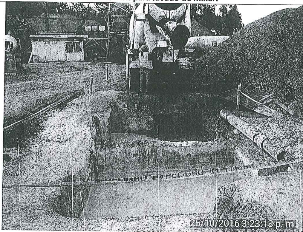
Fotografía 11. Piscinas de sedimentación para lavado de mixer.
