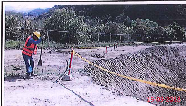
Colocación de barandillas de seguridad en pretratamiento
