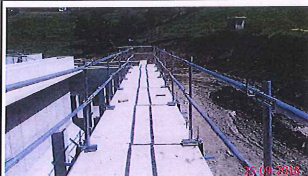
Colocación de barandillas de seguridad en pretratamiento
