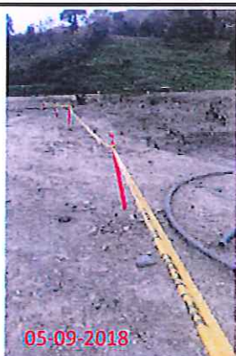
Colocación de balizas o colombinas con cinta para delimitar áreas de peligro
