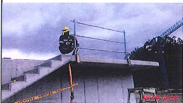
Colocación de barandillas de seguridad en pretratamiento
