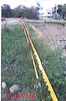
Colocación de balizas o colombinas con cinta para delimitar áreas de peligro/ Colocación de capuchones en varillas
