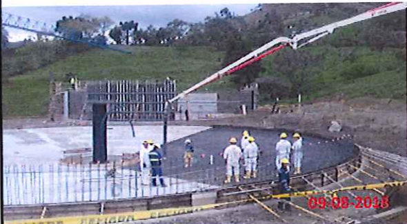
FIGURADO Y ARMADO DE HIERRO EN DECANTADOR PRIMARIO
