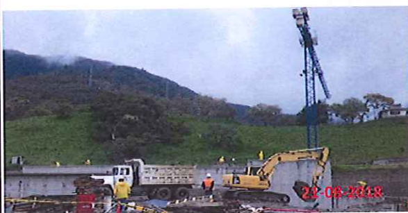
EXCAVACIÓN PARA COLOCACIÓN DE TUBERIA DEL BY PASS
