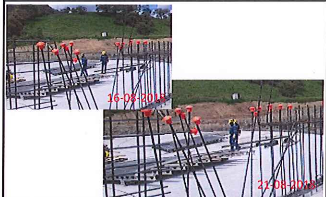
Colocación de balizas o colombinas con cinta para delimitar áreas de peligro/ Colocación de capuchones en varillas
