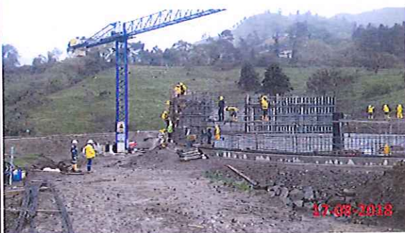
FIGURADO DE HIERRO EN DECANTADORES
