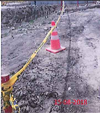
Colocación de balizas o colombinas con cinta para delimitar áreas de peligro/ Colocación de capuchones en varillas
