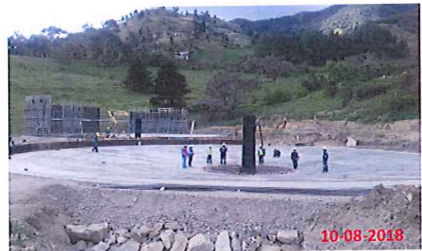
FIGURADO Y ARMADO DE HIERRO EN DECANTADOR PRIMARIO
