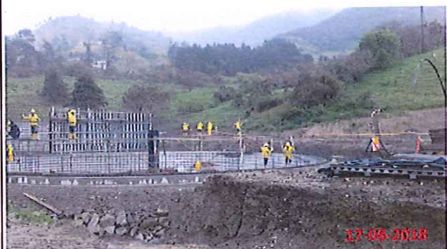
FIGURADO DE HIERRO EN DECANTADORES
