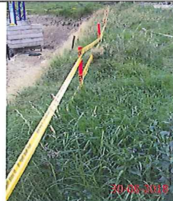
Colocación de colombinas y cintas para delimitar áreas de peligro
