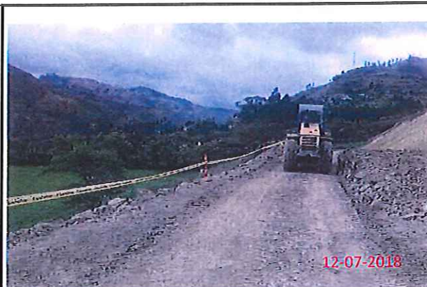
Colocación de balizas o colombinas con cinta para delimitar áreas en colector
