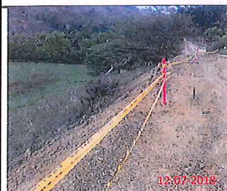
Colocación de balizas o colombinas con cinta para delimitar áreas en colector
