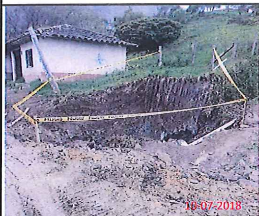
Colocación de balizas o colombinas con cinta para delimitar áreas en colector
