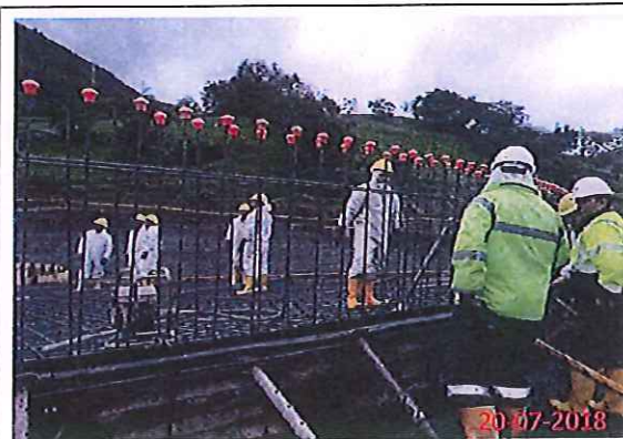
Colocación de capuchones o zetas para cubrir puntales
