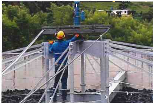
Revisión del motorreductor del filtro percolador PTAR-L
