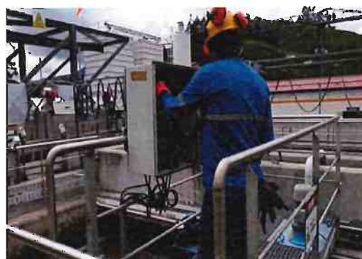
Revisión conexión eléctrica tableros puentes de desarenado.
