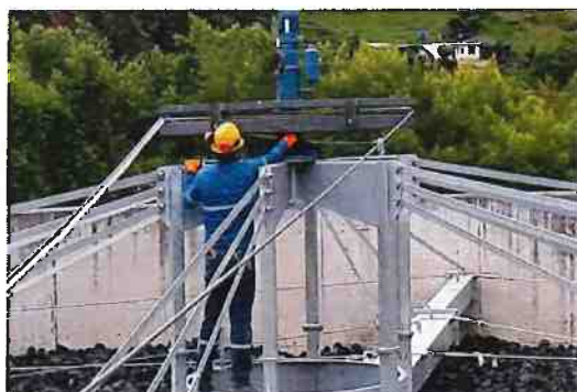
Revisión del motorreductor del filtro percolador PTAR-L
