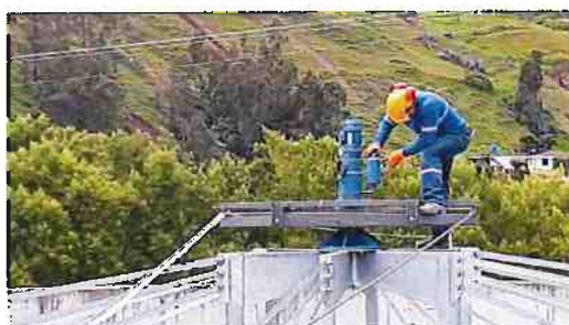
Control de nivel de aceite filtro percolador #2
