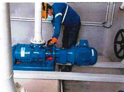
Revisión de bombas purgas de lodos secundarios
