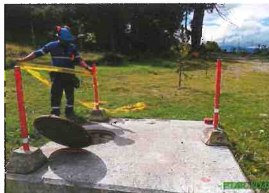
LIMPIEZA E INSPECCIÓN DE DUCTO INGRESO DE AGUA A LA PTAR / DN 1400
