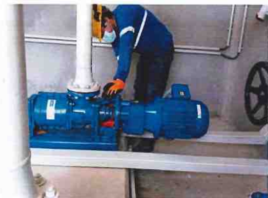
Revisión de bombas purgas de lodos secundarios
