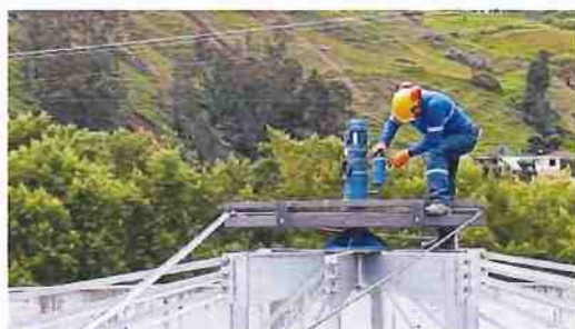
Control de nivel de aceite filtro percolador #2
