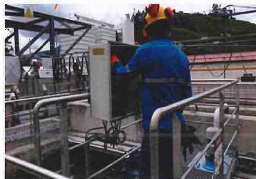
Revisión conexión eléctrica tableros puentes de desarenado.
