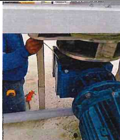
MANTENIMIENTO TORNILLOS DE FANGOS
