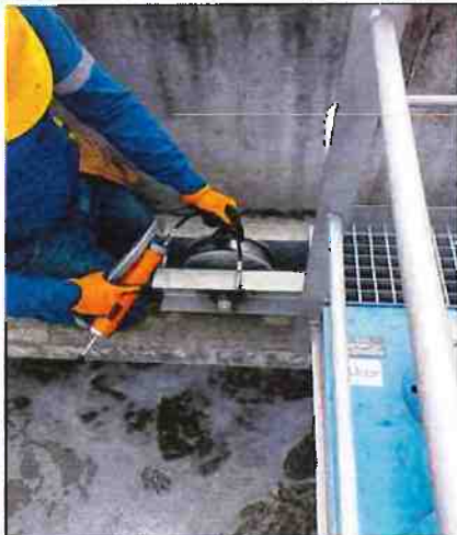
MANTENIMIENTO PUENTES DESARENADORES
