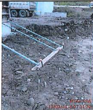
COLOCACIÓN DE CAPUCHONES EN PUNTALES/ REUBICACIÓN DE LETREROS CONFORME LOS RIESGOS
