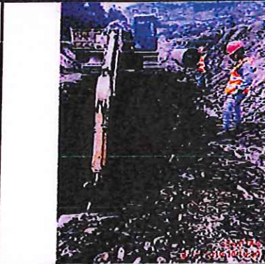
TRABAJOS EN COLECTOR: CONFORMACIÓN DE VIAL DEL COLECTOR/COLOCACIÓN DE TUBERIA PRFV EN COLECTOR VIAL
