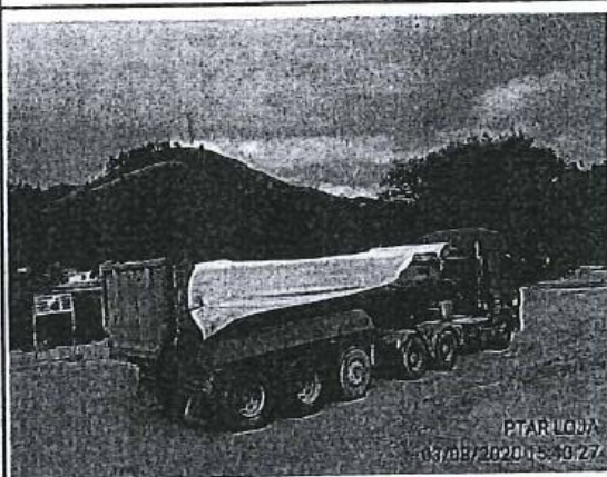
COLOCACIÓN DE LONA EN VOLQUETAS PARA EVITAR CAIDA DE MATERIAL TRANSPORTE CANTERA-OBRA
