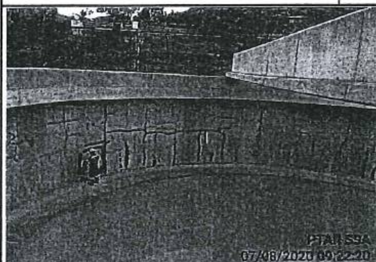
IMPERMEABILIZACIÓN DE PAREDES INTERIORES ESPESADORES DE FANGOS
