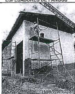
COLOCACIÓN DE EMPASTADO DE DESHIDRATACIÓN
