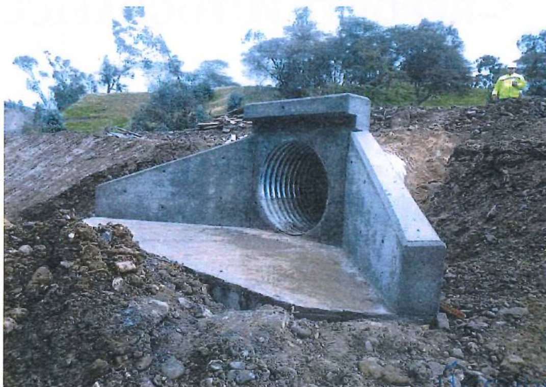
POZO ALCANTARILLA PK 0+220, HORMIGON F'C=280kg/cm 2
