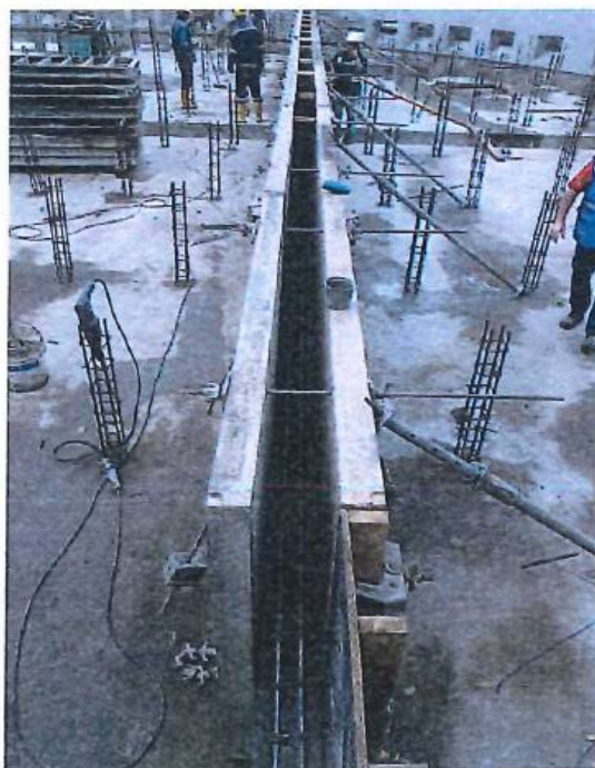
ENCOFRADO EN VIGAS Y PILARES
