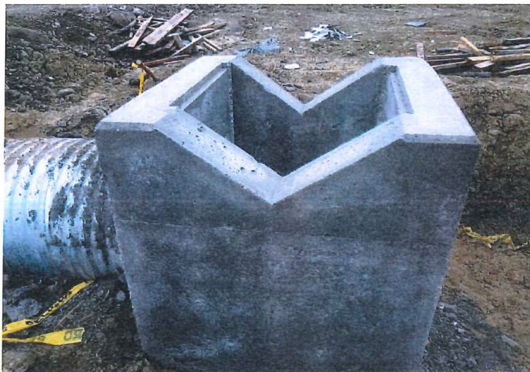
FUNDICION ALETAS DE ALCANTARILLA PK=0+220, HORMIGON F'C=280kg/cm 2
