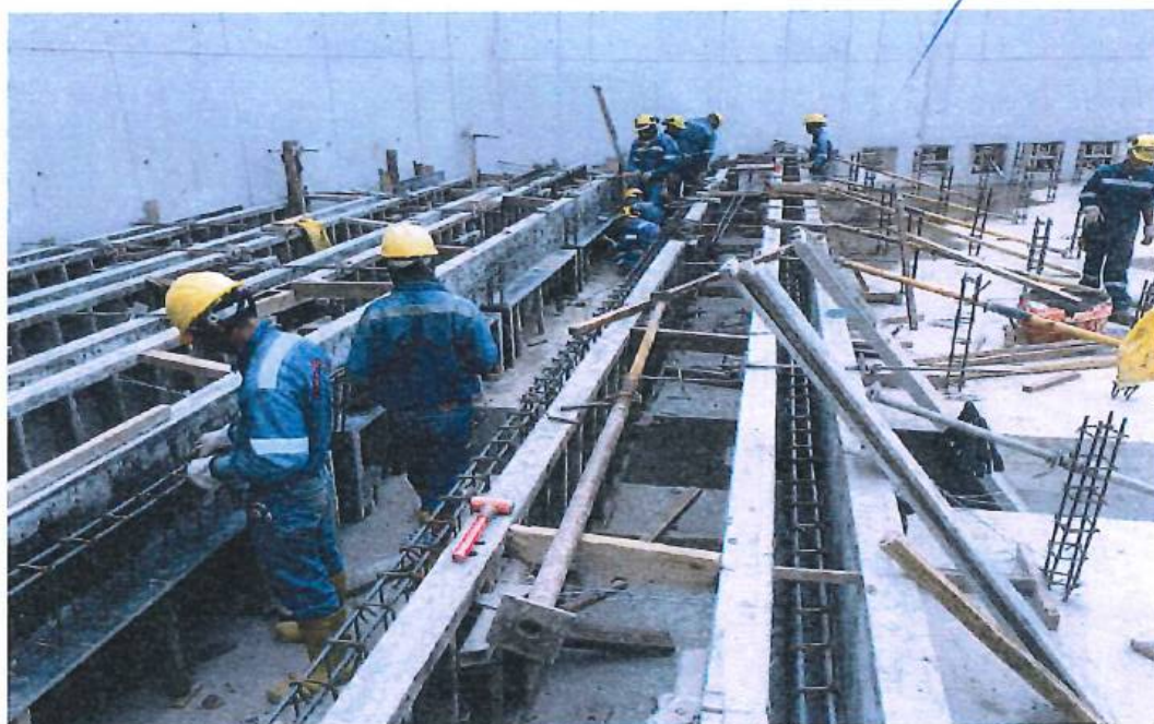
ENCOFRADO EN VIGAS Y PILARES
