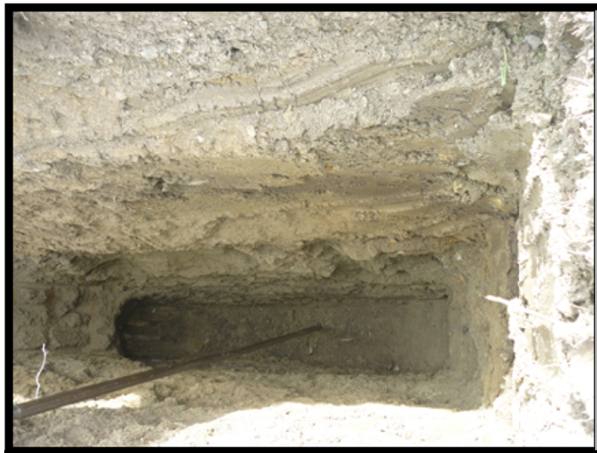
PRESENCIA DE NIVEL FREÁTICO A 3,6 M EN LA CALICATA N° 7 FOTO N° 16
