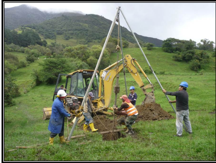
PRESENCIA DE NIVEL FREÁTICO A 3,4 M EN LA CALICATA N° 12 - FOTO N° 26
