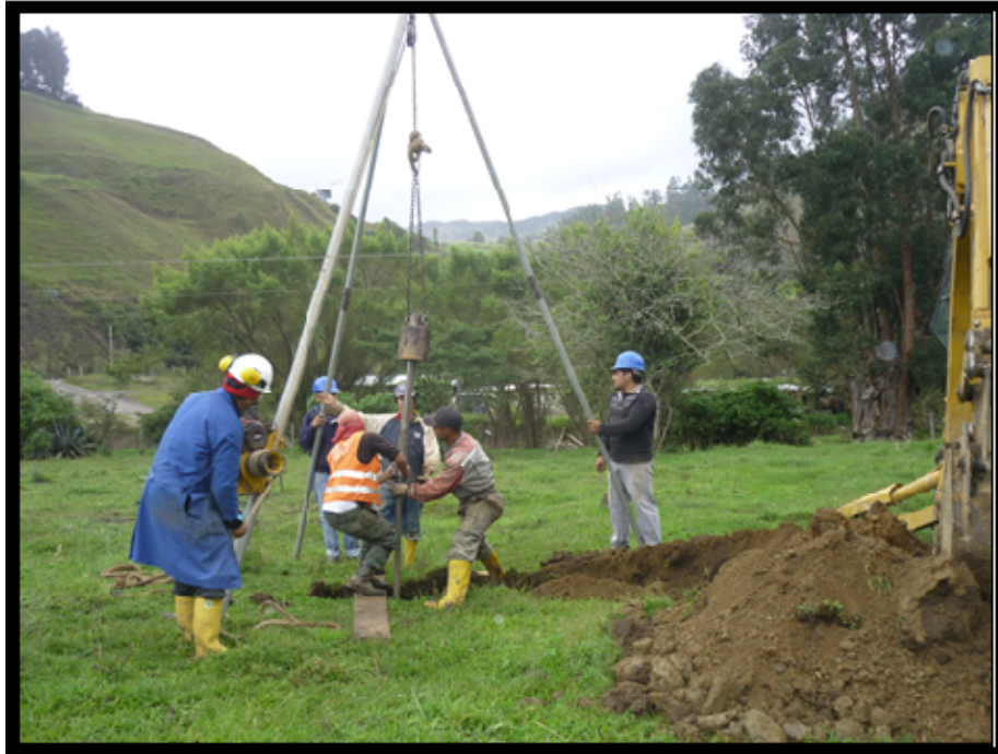
PRESENCIA DE NIVEL FREÁTICO A 4 M EN LA CALICATA N° 11 - FOTO N° 24
