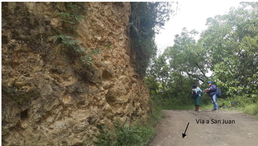
Foto 10. Aglomerado sedimentario por la vía a San Juan, nótase el talud casi vertical que se mantiene relativamente estable
