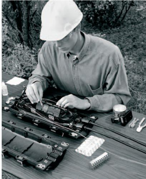
Fig. 8. Procedimiento de armado de manga de empalme lineal.
