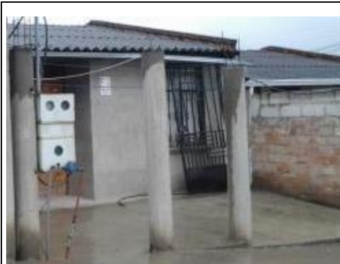
Foto 23. Casa instalaciones de agua y luz
