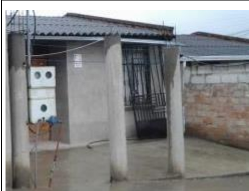
Foto 30. Casa instalaciones de agua y luz
