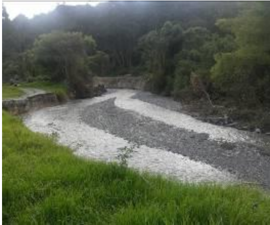
Figura 21. Escombrera 1 identificada en los márgenes de protección del río Malacatos de propiedad de la Universidad Nacional de Loja (UNL)
