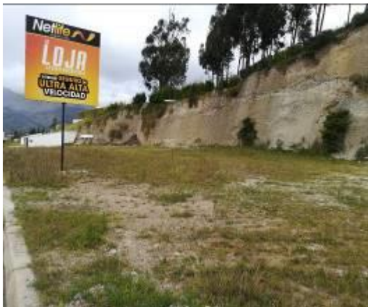
Figura 23. Escombrera 3 identificada en la Funeraria Jardines del Zamora localizado en la vía de integración barrial de la ciudad de Loja.
