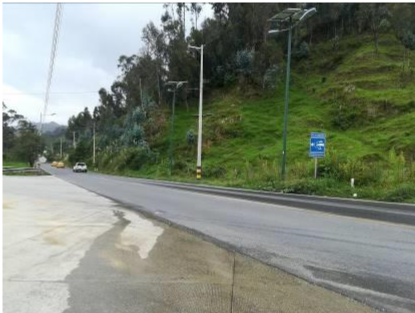
Foto 2. Final del proyecto en la intersección del Puente del Paso Lateral con vía E-682
