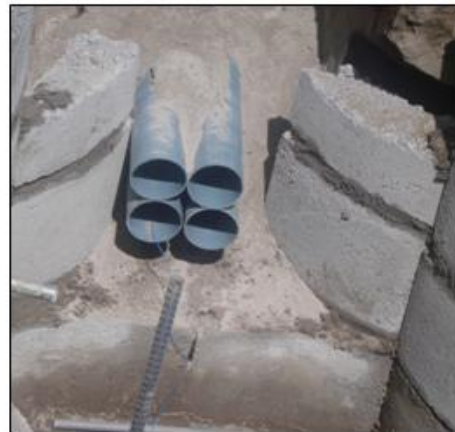
CONSTRUCCIÓN DE DINTEL Y BOQUILLA. (EJ: CANALIZACIÓN DE 4 VÍAS)
