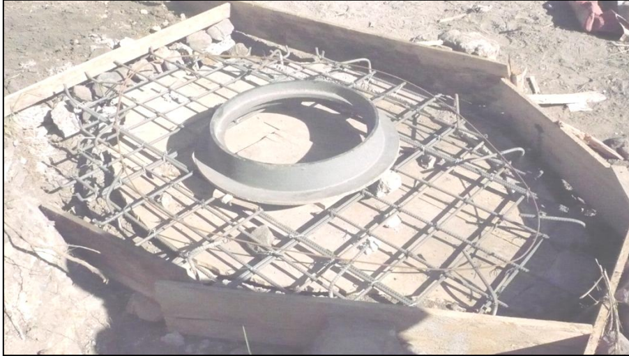
Figura 6-5: Encofrado y armadura de pozo en acera
