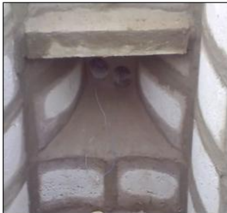
CONSTRUCCIÓN DE DINTEL Y BOQUILLA. (EJ: CANALIZACIÓN DE 4 VÍAS)
