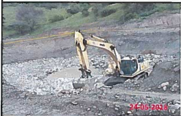
PEDRAPLEN CON PIEDRA 30 A 50 cm CONFORMADO A MÁQUINA PTAR-RN-001
