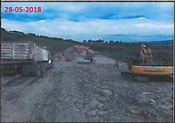
RELLENO COMPACTADO CON COMPACTADOR MECANICO, MATERIAL DE EMJORAMIENTO Y TOMA DE DENSIDADES
