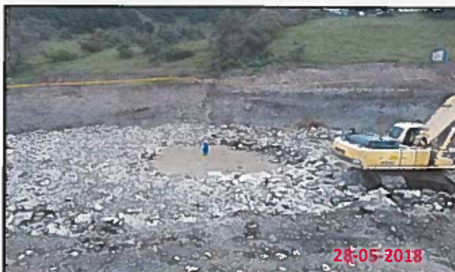
PEDRAPLEN CON PIEDRA 30 A 50 cm CONFORMADO A MÁQUINA PTAR-RN-001
