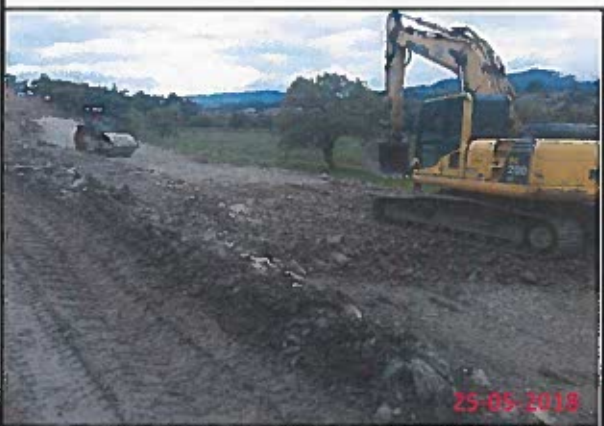
RELLENO COMPACTADO CON COMPACTADOR MECANICO Y MATERIAL DE MEJORAMIENTO PTAR009
