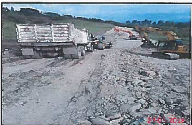
RELLENO COMPACTADO CON COMPACTADOR MECANICO Y MATERIAL DE MEJORAMIENTO PTAR009
