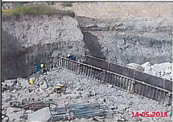
ENCOFRADO RECTO EN MUROS DE ESTRUCTURA Y ALZADO PTAR007
