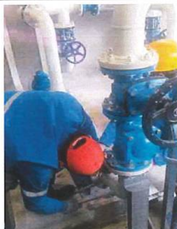
MANTENIMIENTO BOMBAS DE TORNILLO
