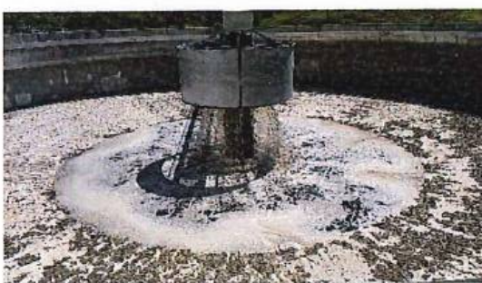
Llenado decantador primario
