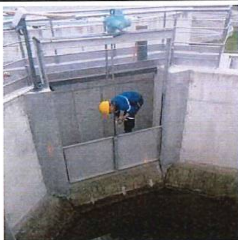
MANTENIMIENTO COMPUERTAS
