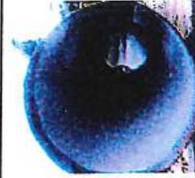
PASAMUROS TAG 20.03 PARA SALIDA DECANTADORES PRIMARIOS 1 Y 2 (DN 1000)
