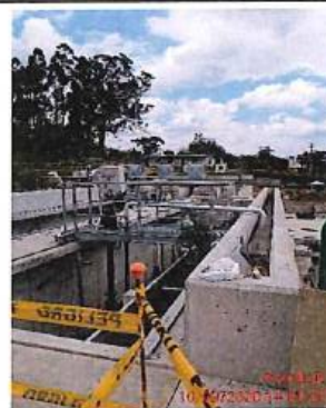
IMPLEMENTACIÓN DE EQUIPOS MECÁNICOS EN DESARENADOR
