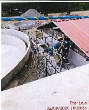
COLOCACIÓN DE MAMPOSTERIA BAJO CUBIERTA DE BOMBEO DE FANGOS SECUNDARIOS
