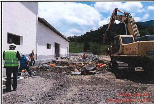
EXCAVACIÓN PARA CIMENTACIÓN DE SILOS
