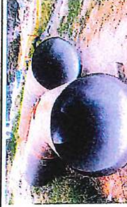
PASAMUROS TAG 20.02 PARA ENTRADA DECANTADORES SECUNDARIOS 1 Y 2 (DN800)
