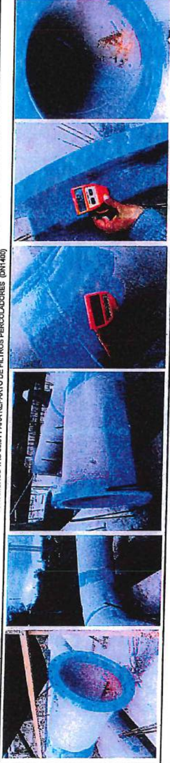
PASAMUROS TAG 30.02 PARA REPARTO DE FILTROS PERCOLADORES 1 Y 2 (DN1400)
