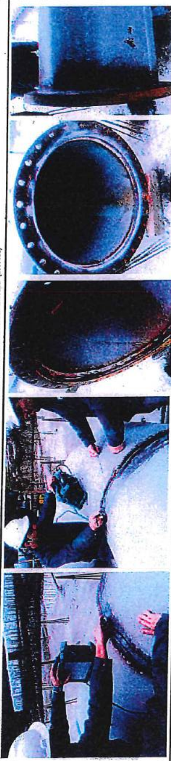
PASAMUROS TAG 30.02 PARA REPARTO DE FILTROS PERCOLADORES 1 Y 2 (DN800)
