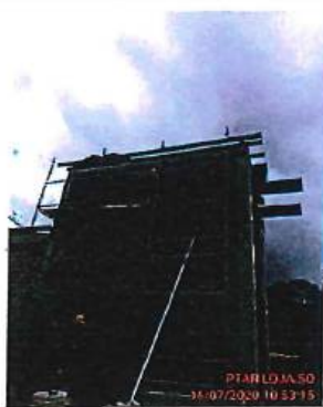
COLOCACIÓN E INSTALACIÓN DE ANDAMIOS Y ENCOFRADOS PARA VIGAS DEL EDIFICIO DE CLORACIÓN
