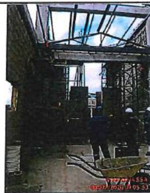
COLOCACIÓN E INSTALACIÓN DE ANDAMIOS Y ENCOFRADOS PARA VIGAS DEL EDIFICIO DE CLORACIÓN
