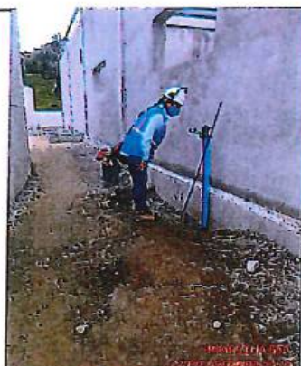
PRUEBA HIDROSTATICA DE TUBERIA DE REDES DE SERVICIO
