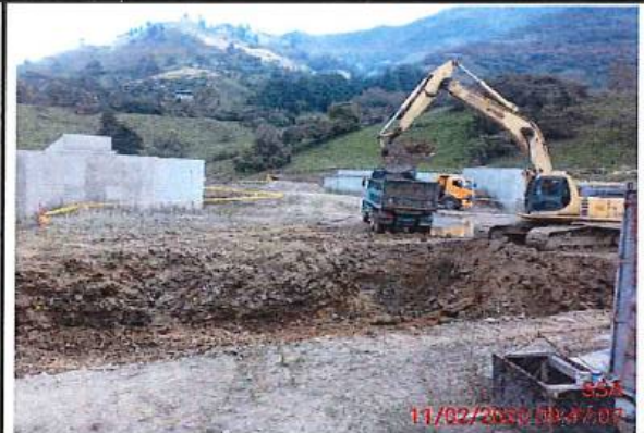
Excavaciones para colocación de piedra
