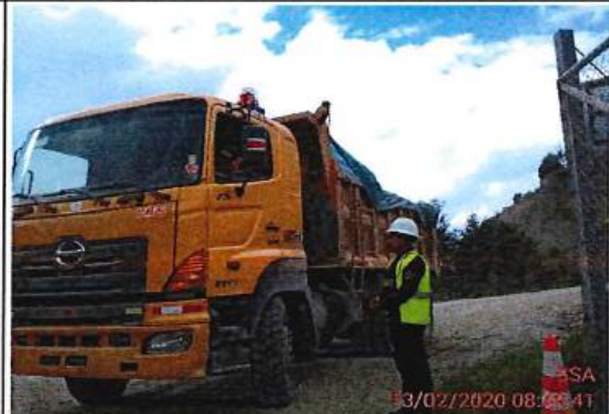
COLOCACIÓN DE LONA EN VOLQUETAS PARA EVITAR CAIDA DE MATERIAL TRANSPORTE CANTERA-OBRA
