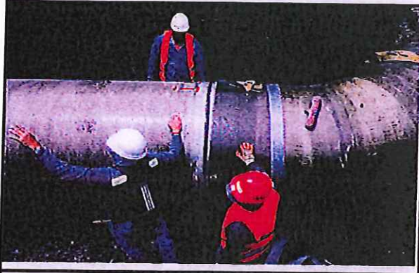
INSTALACIÓN DE TUBERÍAS DE PRFV. D=1400 \text{ mm}
