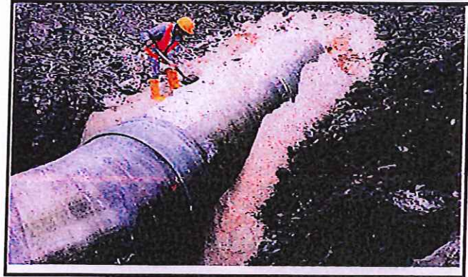
RELLENO DE CAMA DE ARENA EN BYPASS
