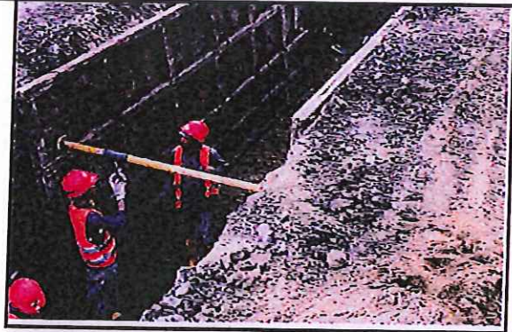
COLOCACIÓN DE ENTIBADOS METÁLICOS COLECTOR MARGINAL
