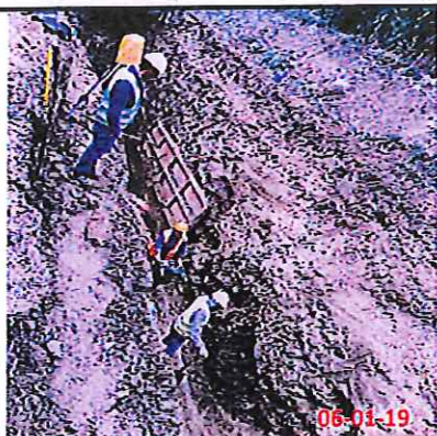
TRABAJOS EN COLECTOR COLOCACIÓN DE TUBERIA / TRABAJOS EN REPLANTILLO EN ESPESADOR DE FANGOS
