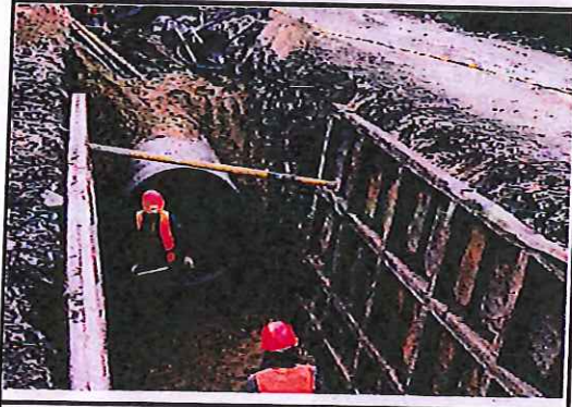
RELLENO DE CAMA DE ARENA EN COLECTOR MARGINAL
