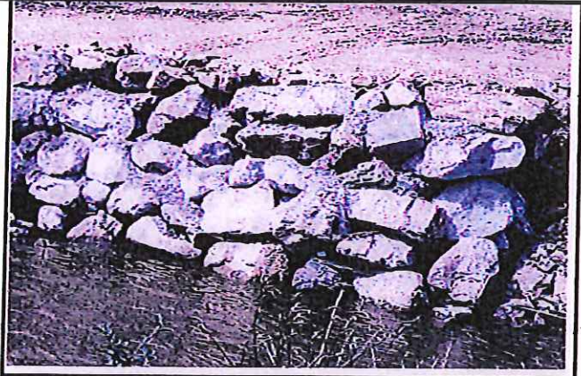
BASES DE PUENTE, COLOCACIÓN DE PIEDRA Y HORMIGÓN DE LIMPIEZA f_c = 140 \text{ kg/cm}^2
