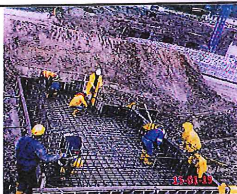
TRABAJOS EN COLECTOR COLOCACIÓN DE TUBERIA / TRABAJOS EN REPLANTILLO EN ESPESADOR DE FANGOS
