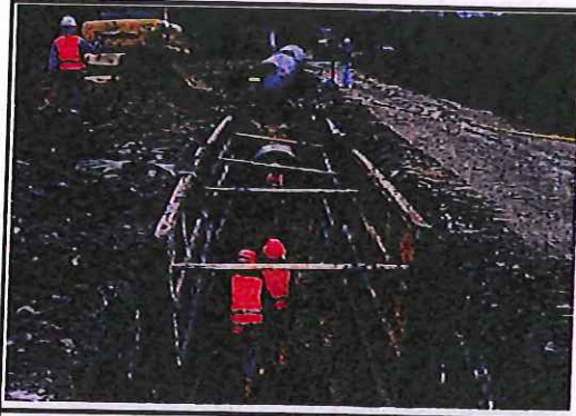
COLOCACIÓN DE ENTIBADOS METÁLICOS COLECTOR MARGINAL
