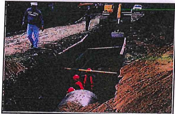
RELLENO DE CAMA DE ARENA EN COLECTOR MARGINAL
