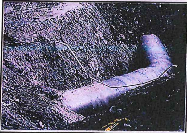
RELLENO CON MATERIAL DE SITIO EN BYPASS
