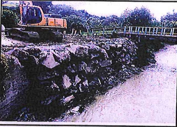
BASES DE PUENTE, COLOCACIÓN DE PIEDRA Y HORMIGÓN DE LIMPIEZA f_c = 140 \text{ kg/cm}^2
