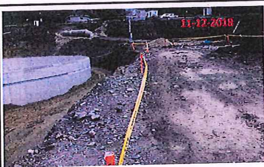
Colocación de balizas o colombinas con cinta para delimitar áreas de peligro
